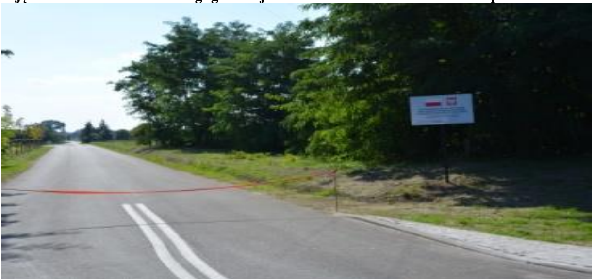
Zdjęcie nr 2. Przebudowa drogi gminnej nr 690006Z Breń- Klasztorne Etap I
