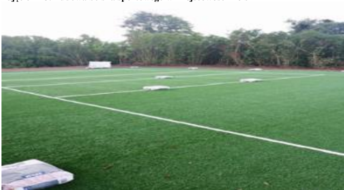
Zdjęcie nr 3. Budowa boiska sportowego w miejscowości Kolsk
