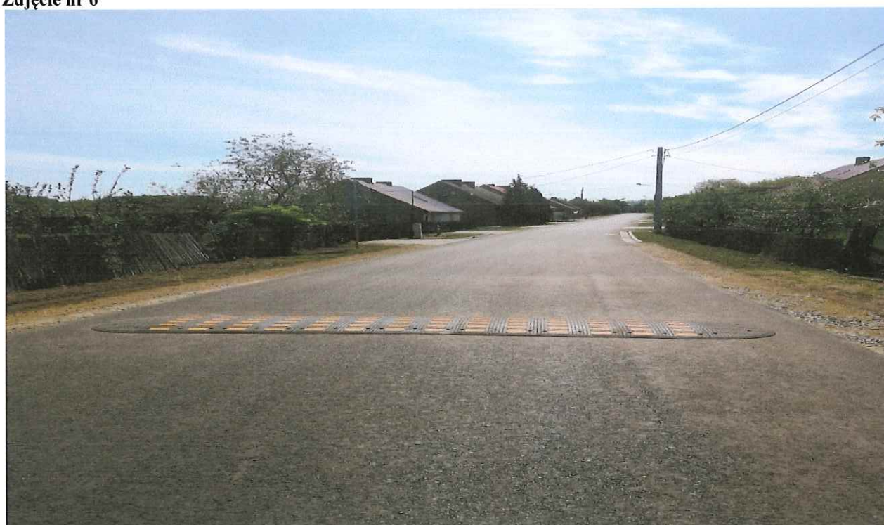
Droga po zakończeniu inwestycji w roku 2020. Zdjęcie nr 6
