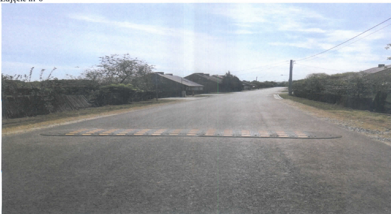
Droga po zakończeniu inwestycji w roku 2020. Zdjęcie nr 6
